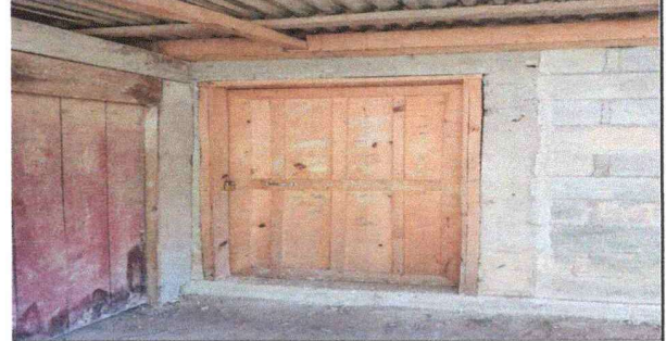
Foto 2: Cambio de puerta a metal
