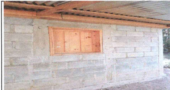
Foto 3: Cambio de ventana a metal
