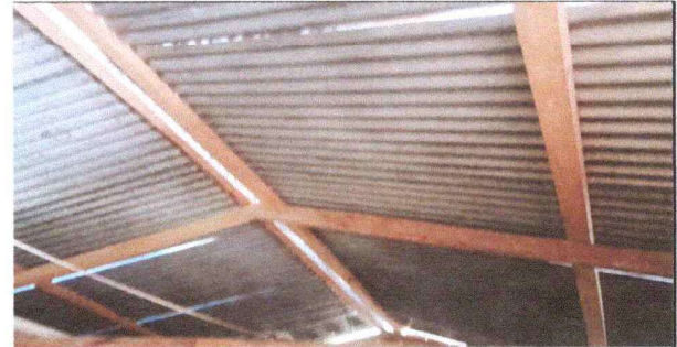
Foto 4: Cambio de costaneras y tijeras a metal
