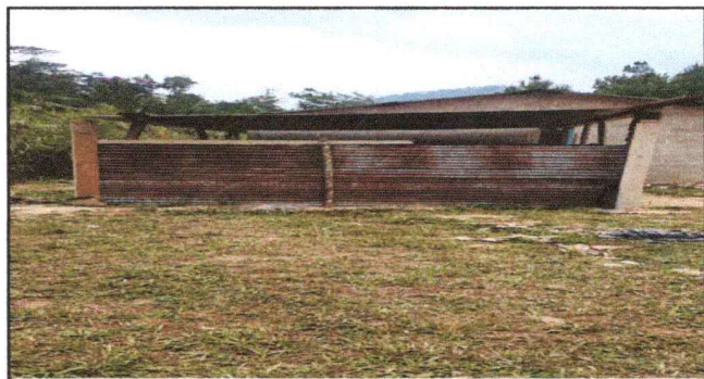
Foto 6: Instalación de baños
